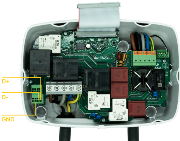
Figure A1.6 Installation du câblage dans Wallbox Commander 2
