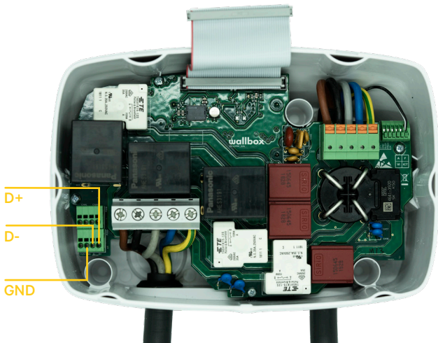
Fig. A1.6 Installazione del cablaggio per Wallbox Commander 2
